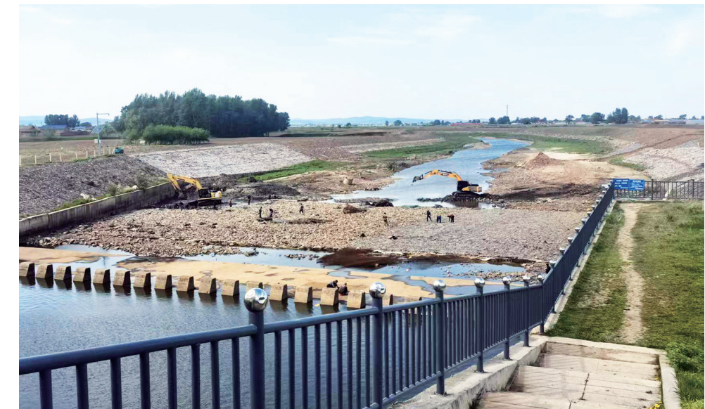
范家拦河闸水毁修复工程现场。
