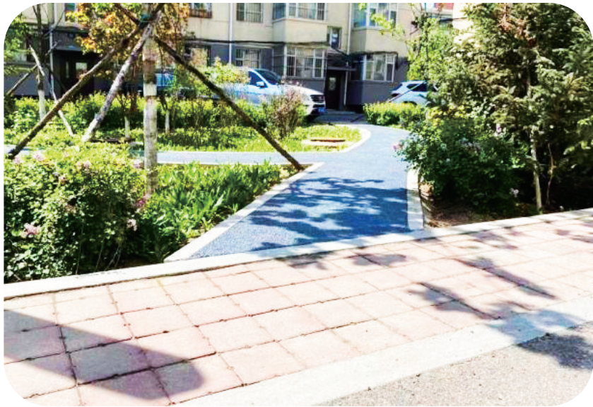
小区改造后的透水人行道。
