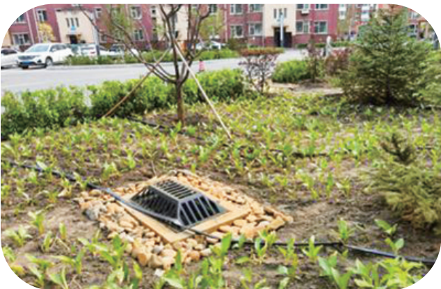
小区下沉式绿地。
