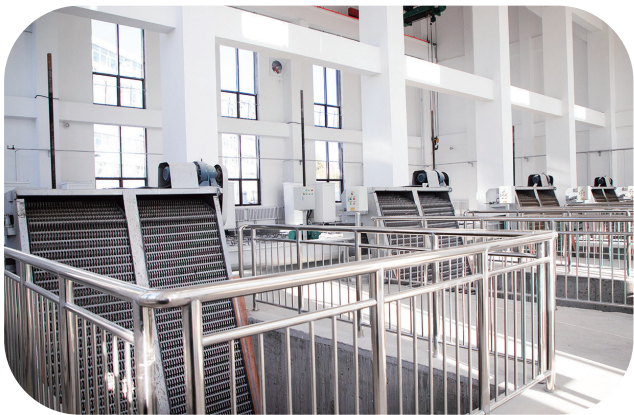
新建的沿江泵站。
