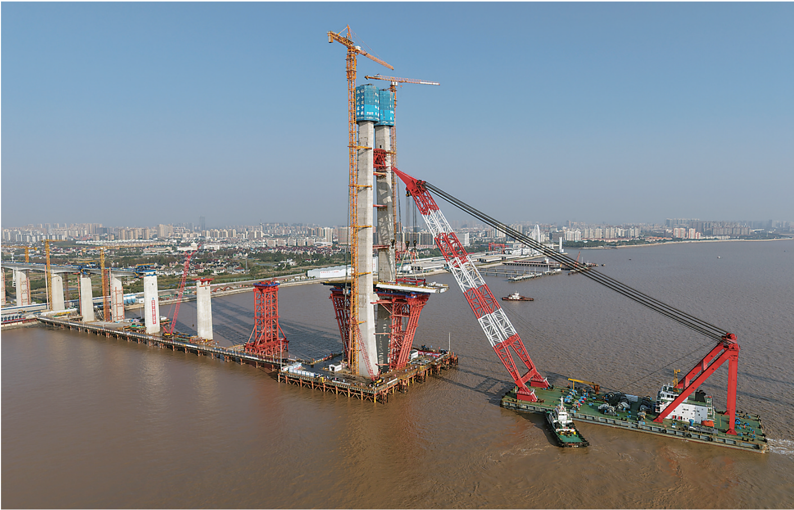
图为11月15日拍摄的杭州湾跨海铁路桥北航道桥钢梁架设现场(无人机照片)。
