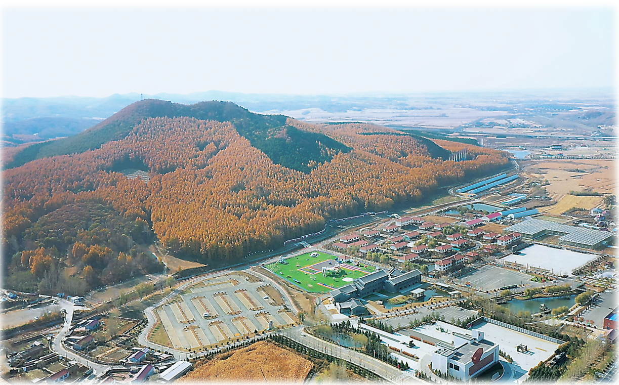
长春市九台区马鞍山村全景。
