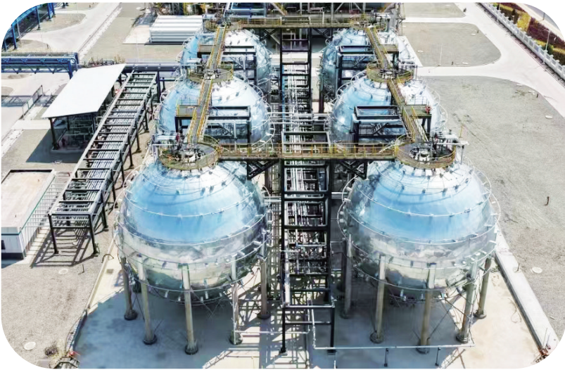
吉林中行支持大安风光制绿氢合成氨一体化示范项目顺利投产。
