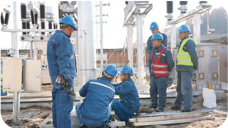
蛟河江密峰变电站66千伏线路新建工程施工现场。
