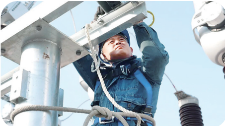
在工程施工中工人登高作业。（本栏图片均为资料图片）
