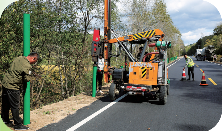
施工人员正忙着为新修的公路安装安全设施。
