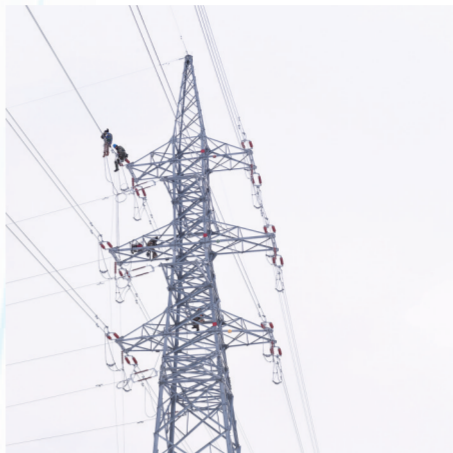
国网吉林供电公司员工在66千伏保林分乙线开展引流线调整作业。庄淑英 摄
