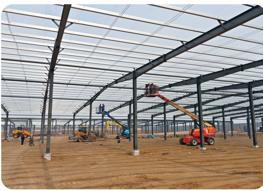
位于长春九台经济开发区的长春数字医药产业园二期项目正在进行钢结构搭建。
