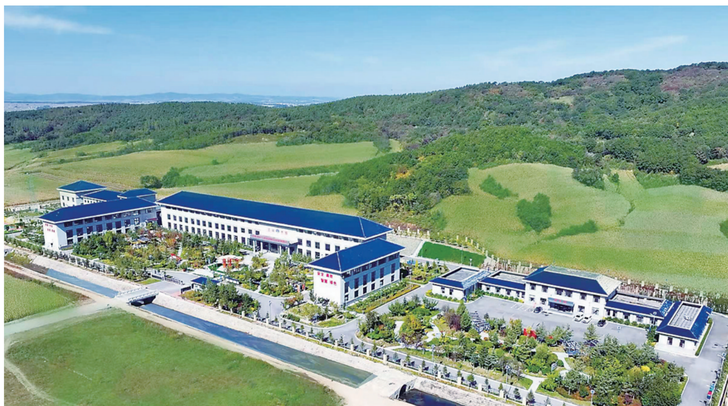
吉林省中部城市引松供水工程冯家岭分水枢纽。
