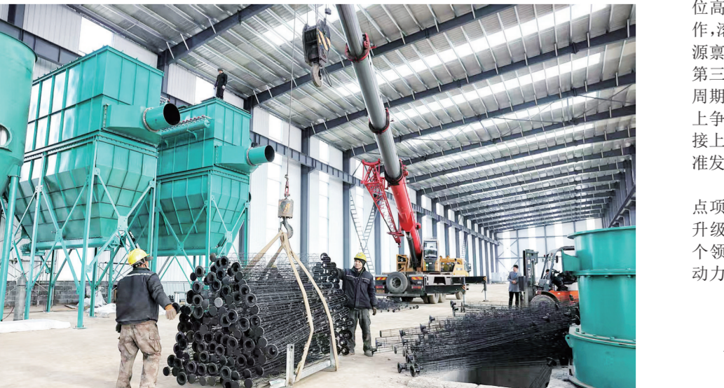
中温集团新能源电池负极材料生产线设备升级改造项目建设现场。 柳河县委宣传部供图
