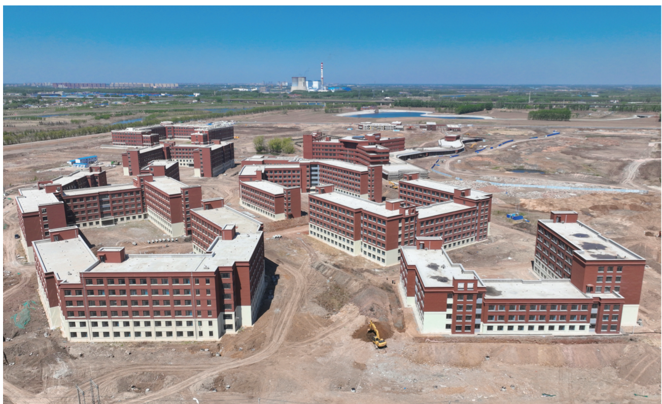
日前,位于长春新区南湖开发区的长春师范大学易地新建项目(一期工程)进入冲刺阶段,目前主体建筑已完工。建成后,将极大改善当地办学条件,在技术服务、人才培养、产业结构调整等方面,全面促进长春新区高质量发展。本报记者 潘硕 摄
