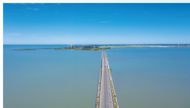
建设拦污坝、拦污坝大桥和拦污闸，守护查干湖碧水蓝天。图为查干湖大桥。
