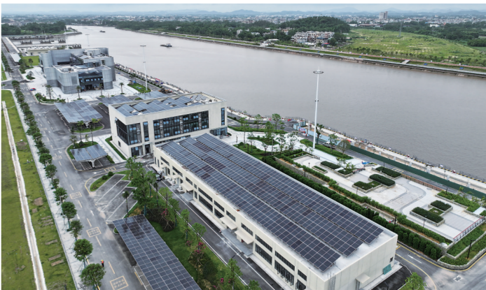
平陆运河钦州水上服务区，坐落于广西钦州市城区段平山岛左岸。该服务区规划13个专业化泊位，全泊位适配5000吨级江海直达船。
