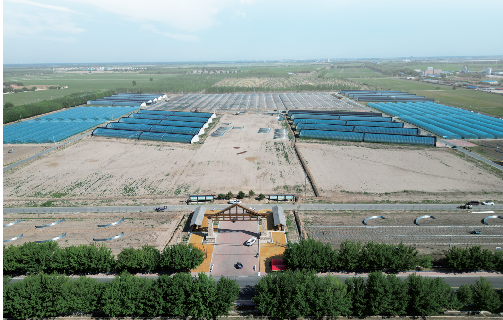
今年,黑水西瓜产业园新建冷棚108栋,预计7月底竣工。
