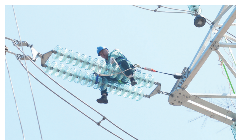
国网白山供电公司初步构建了电网可视化装置+机器人巡视+无人机巡检+远程调度指挥的电网运维模式，提升了电网精益化管理水平。图为工作人员在安装分布式故障诊断装置，可远程自动发现和判断输电线路安全运行隐患。赵洪涛 摄
